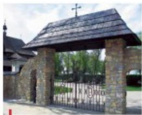
Główna brama nowego ogrodzenia.
