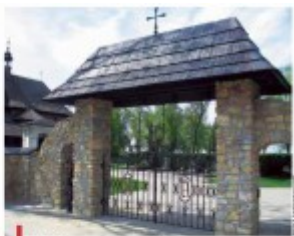
Obrona brama nowego ogrodzenia
