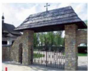
Obrona brama nowego ogrodzenia.
