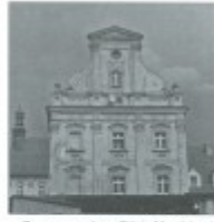
Po wyprawdzie siostry Magdalena, w części budynku powstał szpital dla dzieci. Po I Wojnie Światowej w budynku klasztornym powstało też schronisko młodzieżowe, sanatorium i dom starców. W roku 1953 kardynał Adolf Szypulski odkupił budynek od państwa i zakładał tam placówkę „Caritas”. W klasztorze zamieszkały siostry Jachdzianki i siostra siewcz. Siostry prowadziły też szkoły dla dziewcząt w zakresie prowadzenia domu, ogrodu i uprawy psów. Klasztor przetrwał nawałnicą II Wojny Światowej i pełni swoją funkcję do dziś.
