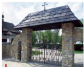
Główna brama nowego ogrodzenia.
